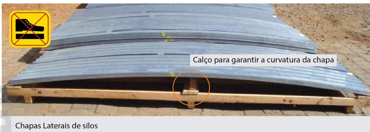
Figura 13 - Forma correta da armazenagem das chapas laterais em obra.
